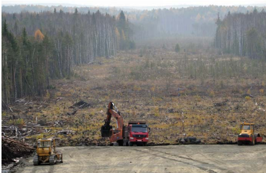
Строительство дороги. Фото Алексея Кунилова
