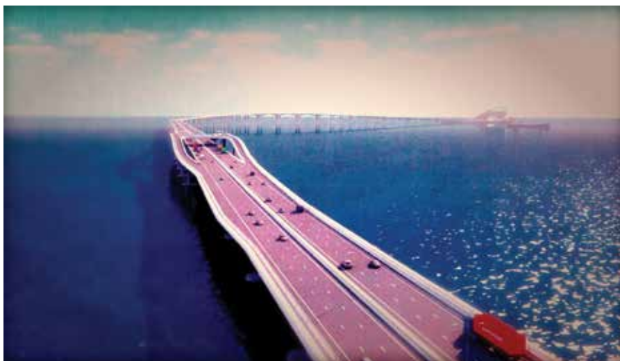
Рис. 3. Самый длинный мост (эстакада) «Масао», выполненный фирмой «Бауэр»
