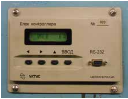
Рис. 3. Микропроцессорный терминал защиты фидера 825 В АЗМ-2
