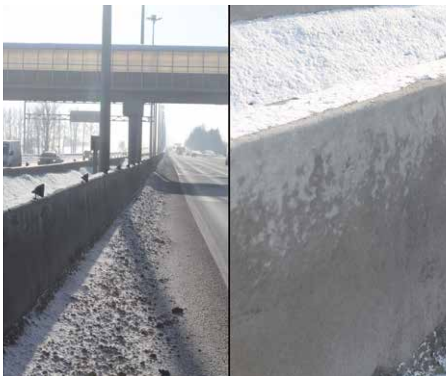
Рис. 4. Дорожное ограждения трассы М-20 из наномодифицированных бетонных смесей после двух лет эксплуатации в агрессивных условиях
