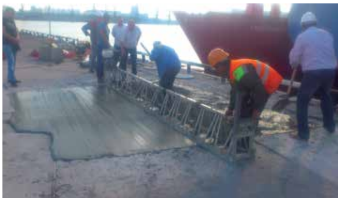
Рис. 3. Ремонт дорожной плиты причала контейнерного терминала (слева) и аэродромного покрытия на территории аэропорта «Пулково» (справа) с применением наномодифицированных бетонных смесей
