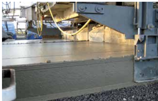
Рис. 3. Ремонт дорожной плиты причала контейнерного терминала (слева) и аэродромного покрытия на территории аэропорта «Пулково» (справа) с применением наномодифицированных бетонных смесей
